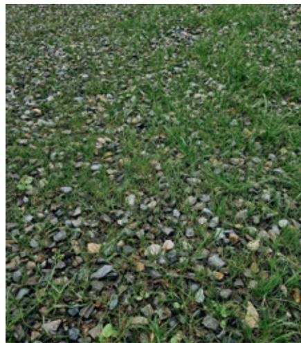
ist mindestens 20cm stark und besteht aus größerem kantigen Schotter (z. B. Korngrößen 0/45 - 0/64), die obere Schicht hat eine Stärke von 15-30cm und besteht aus feinkörnigerem Material (z. B. 0/16 - 0/20), das mit Erde (20%) und Kompost (ca. 5%) vermischt wird. In die Grassamenmischung kann man geeignete Blühpflanzen mischen, die den Wuchs zusätzlich befestigen und optisch aufwerten.
